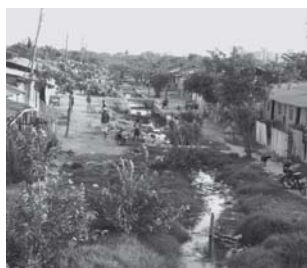
Canales abiertos de aguas residuales en Cartagena, Colombia
