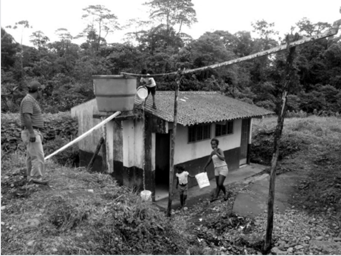
Tanques para recolectar agua lluvia en el Centro Educativo km 92 en la vía Tumaco-Pasto, Municipio de Barbacoas.
