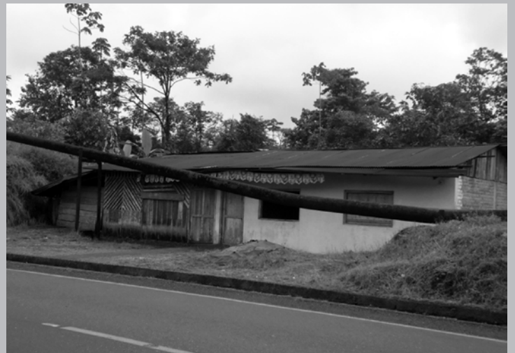
Oleoducto trasandino de Ecopetrol atravesando la carretera en las comunidades de la vía Tumaco-Pasto, 2013.
